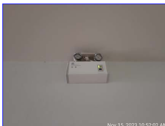
รูปที่ 2.41 เครื่องสำรองไฟฉุกเฉิน
